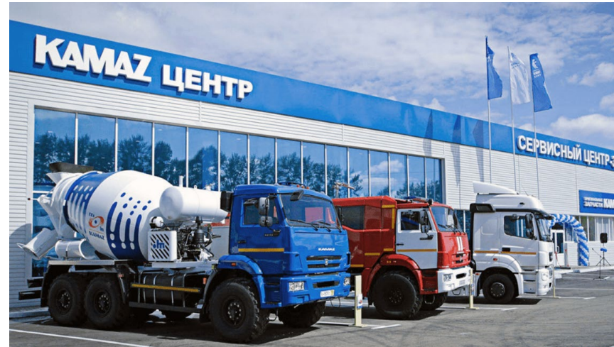
Строительство центров по сервисному, гарантийному и восстановительному ремонту автомобилей и автобусов производства ПАО «КАМАЗ» в Буденновском внутригородском районе г. Донецка
