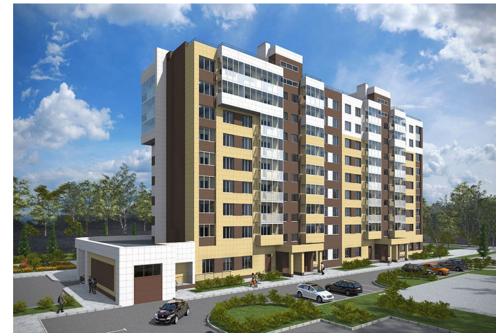
Строительство жилых кварталов многоквартирных домов на земельном участке, ограниченном пр. Ватутина и пр. Б. Хмельницкого, ул. Р. Люксембург и ул. Ермощенко в Ворошиловском внутригородском районе г. Донецка
