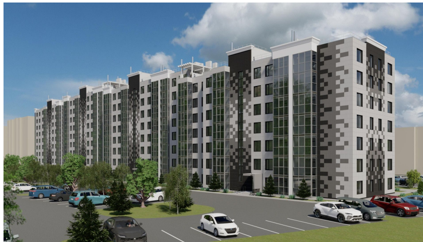
Строительство жилого квартала многоквартирных домов по улице Независимости в Буденновском внутригородском районе г. Донецка
