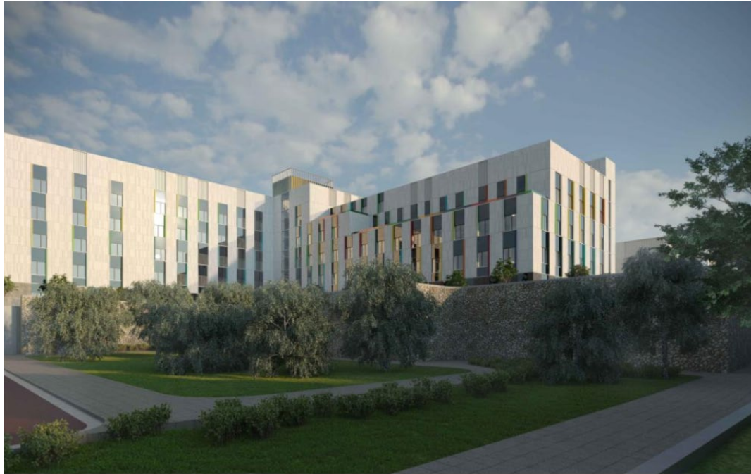
Строительство детского реабилитационного центра им. св. Луки с парковой зоной по проспекту 75-летия футбольного клуба «Шахтер» в Киевском внутригородском районе г. Донецка
