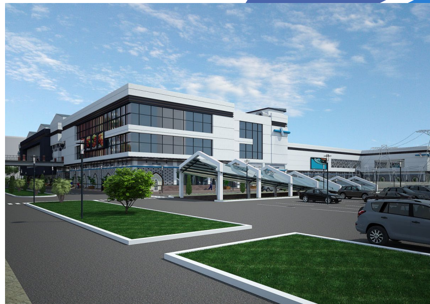
Строительство торгово-развлекательного центра и административно-офисного здания в Кировском внутригородском районе г. Донецка
